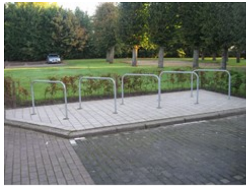
fietsenstalling met aanbindmogelijkheid: ok
